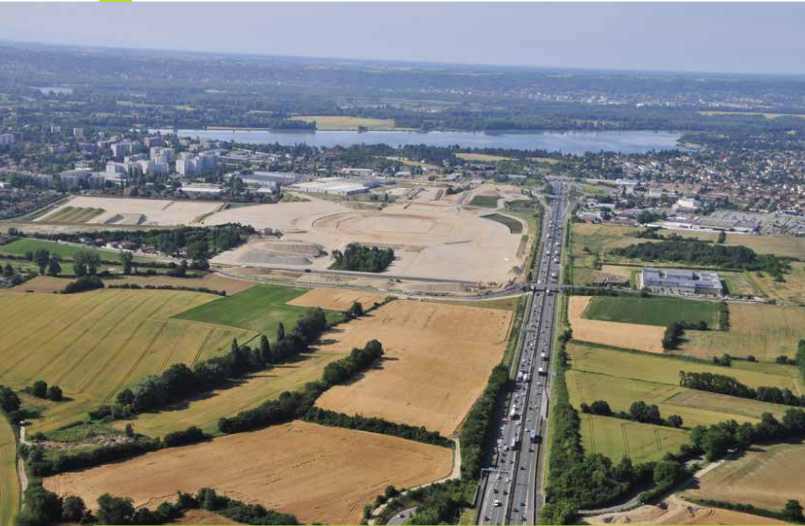
Construction du Grand Stade, 2013. M.P. Ruch - Agence d'urbanisme de Lyon
