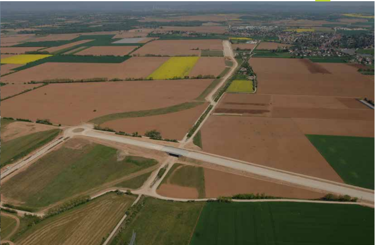
Chantier RhonExpress, 2007. J. Leone - Grand Lyon
